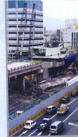
청계고가도로 철거 (2003년) Dismantling of Cheonggye Expressway
