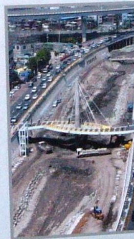
청계천 복원공사 (2005년) Cheonggyecheon Restoration project
