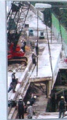
청계고가도로 철거 (2003년) Dismantling of Cheonggye Expressway
