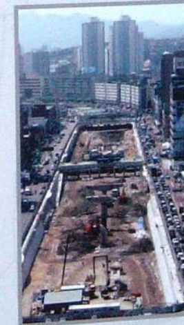
청계천 복원공사 (2005년) Cheonggyecheon Restoration project
