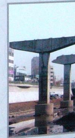
청계천 복원공사 (2005년) Cheonggyecheon Restoration project
