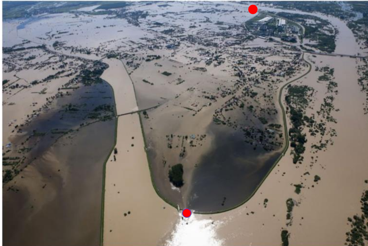
Katastrofalne skutki awarii wałów przeciwpowodziowych na Wiśle: Sandomierz - maj-czerwiec 2010
